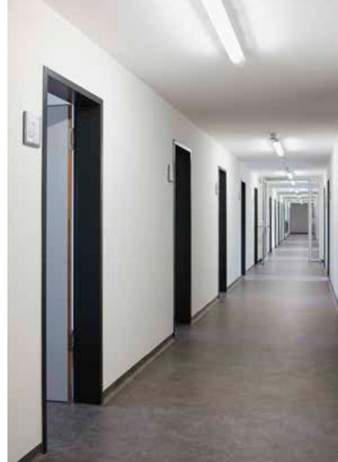
Innenwände haben einen Kern aus einem Metallständerwerk, Holzbal-kendecken mit Rauspundschalung, Ausgleichsdämmung und Zement-schnellestrich trennen die Geschos-se voneinander. Abgehängte Gips-kartondecken bilden die Untersicht der Decken. Das Dach ist äh-nlich den Decken aufgebaut, jedoch
