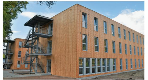
Lärchenholzverschalung besteht die Fassade. Die Außentreppe, die auch als Zugang für das Obergeschoss dienen, sind aus feuerverzinktem Stahl hergestellt und bleiben unlackiert.
